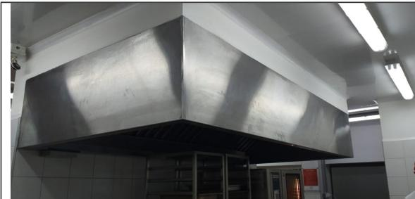
Foto No. 5 Sistema de extracción área de cocción y horneado
